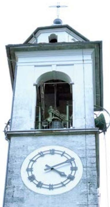
*La seconda campana, divenuta pericolante a causa della rottura della treccia di sostegno, è stata calata all'interno della torre campanaria per permetterle i lavori di ripristino e messa in sicurezza. Al contempo un operaio sta eseguendo lavori di miglioria alla terza campana che, per questo, è stata inclinata di novanta gradi.*
